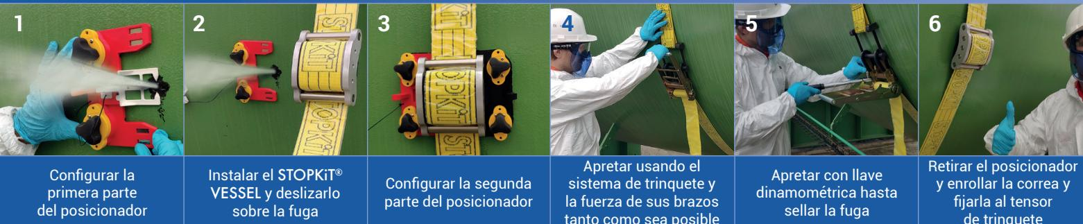
\* Para instalar el STOPKiT® VESSEL sobre un recipiente a presión vertical, una etapa adicional usando un sistema con imanes es necesaria (entre los pasos 1 y 2)
